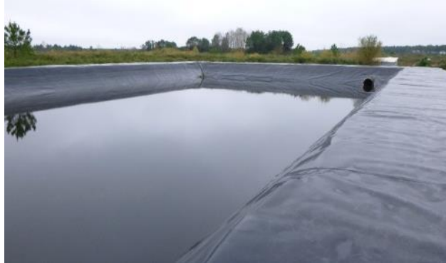
Bassin de rétention ©ETEN Environnement
