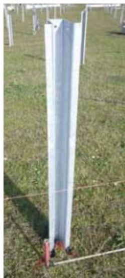
Pieu pour les fondations réduisant les incidences sur l'imperméabilisation des sols
